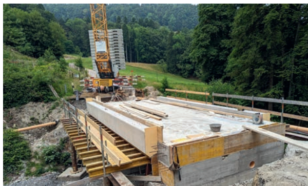
Neue Fahrbahnplatte mit Konsolköpfen.
